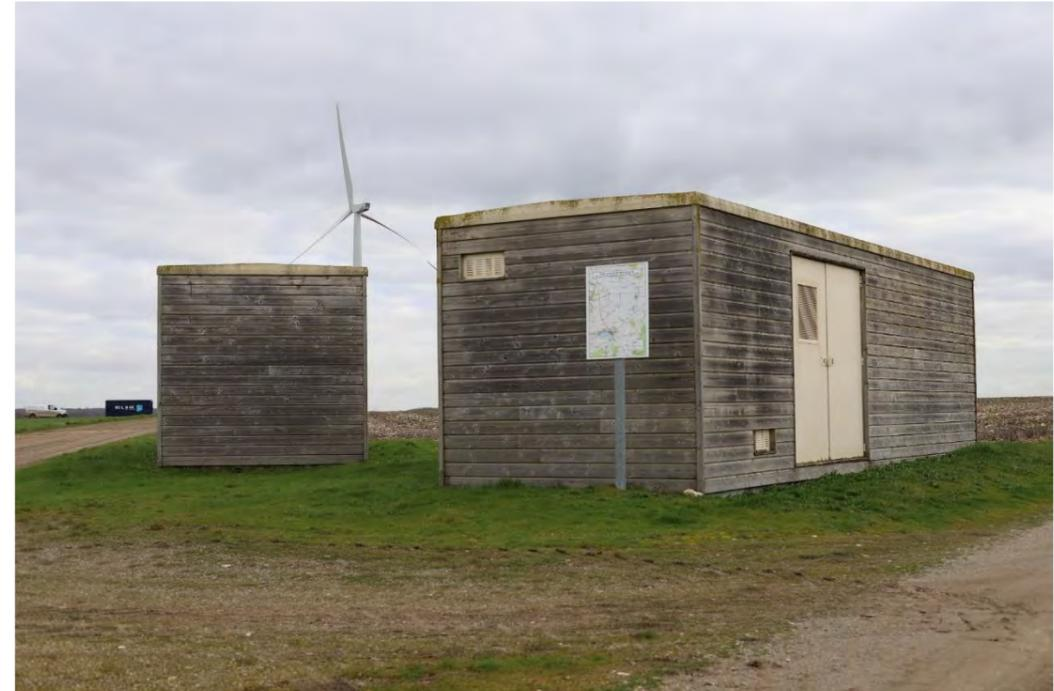
Figure 471 : Exemple de postes de livraison recouverts d'un bardage bois (Source : AEPE-Gingko, 05/02/2020)
